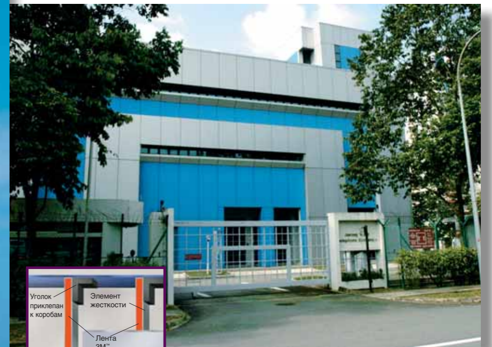
Западная телефонная станция, Юронг, Сингапур. Композитные панели прикреплены к элементам жесткости
