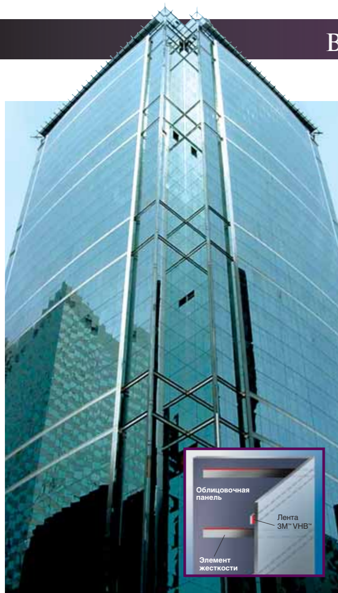
Дирборн Центр, Чикаго, Иллинойс, США. Застройщик: «Копер-Сэйлз Уна-Клад», 2003. Элементы жесткости приклеены к наружным металлическим облицовочным панелям
