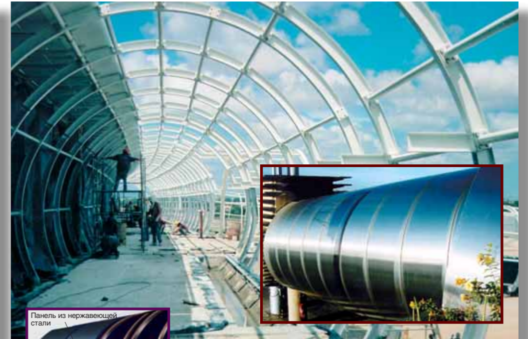
Аэропорт Форталеза, Форталеза, Бразилия. Архитектор: Клаудио Сильва, 1977. Панели из нержавеющей стали приклеены к стальной раме
