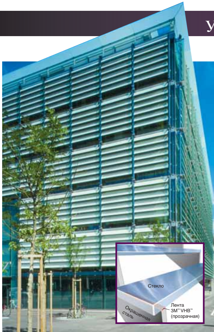
Тамедиа Билдинг, Цюрих, Швейцария. Дизайн фасада: Soder AG, 2001. Стекланные полотна приклеены к окрашенной стальной раме
