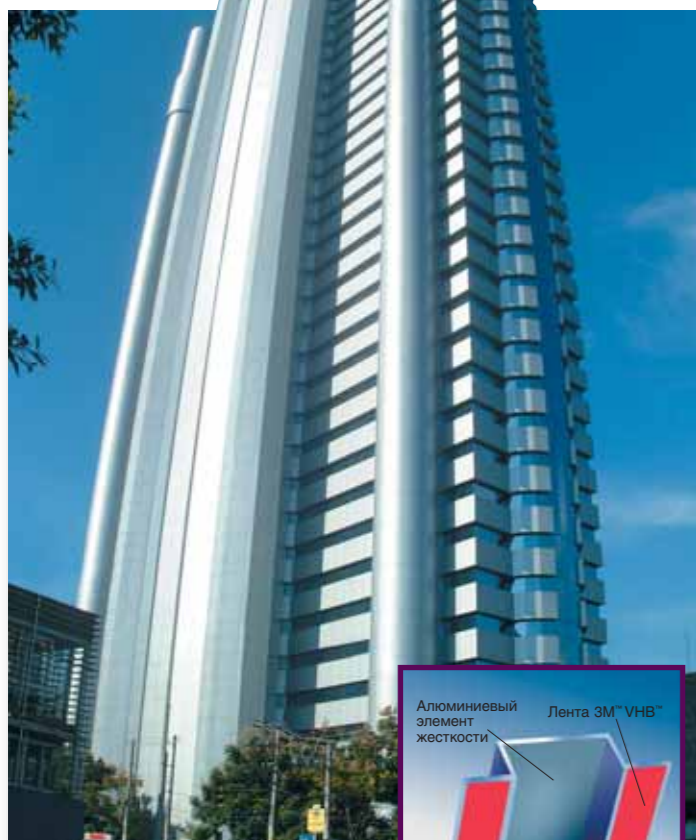
Плаза Центенарио, Сан-Паулу, Бразилия. Архитектор: Карлос Братке, 1995. Алюминиевые элементы жесткости приклеены к композитным панелям
