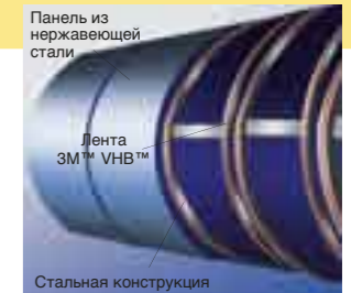
Аэропорт Форталеса, Форталеса (Бразилия), 1998 год Панели из нержавеющей стали, наклеенные на стальную раму
