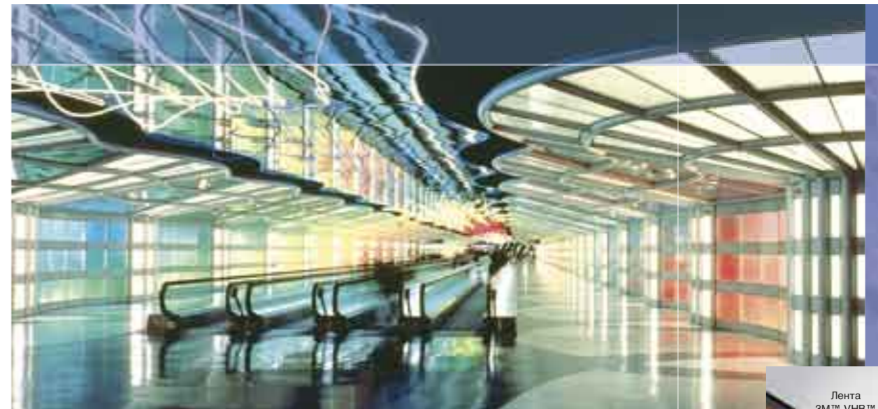
Аэропорт О'Харе, Чикаго, штат Иллинойс (США), 1987 год Архитектурный проект: компания Custom Products of Southgate, CA Композитные панели для потолка с зеркальным покрытием, наклеенные на несущую раму
