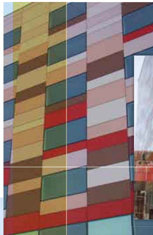
Реконструкция здания завода «Серп и молот». г. Москва 2009 г., (Россия) Остекление: компания ООО «ПК АЛБИТЕК» Структурное остекление с лентой 3М™ VHB™ G23F
