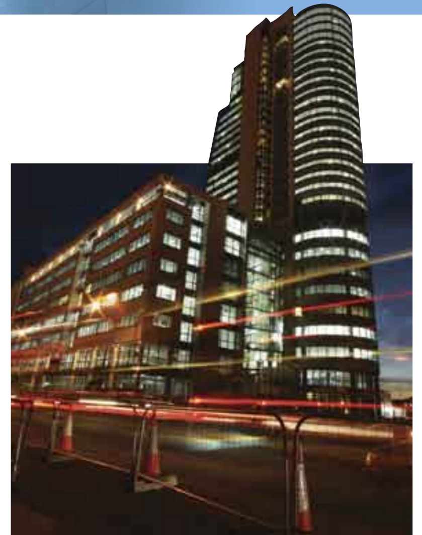
Bridgewater Place, Лидс (Великобритания), 2007 год Архитектурный проект: компания Aedas Ребра жесткости приклеены к архитектурным панелям Ленты 3М™ VHB™ 4611 и 4655 Фотография: www.turnkey.eu.com
